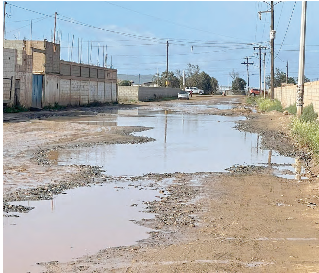
Vecinos deben utilizar rutas alternas por los encharcamientos y el lodo que dejaron las recientes lluvias.
